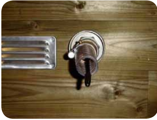
Walslang met verwarmingslint in de slang: vooraanzicht (links) en zijaanzicht (rechts).
