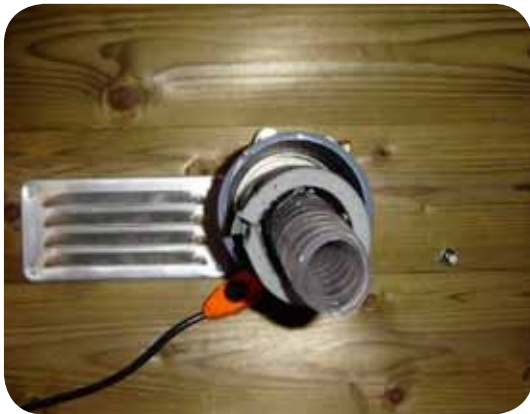
Walslang met verwarmingslint buiten de slang: vooraanzicht (links) en zijaanzicht (rechts).
